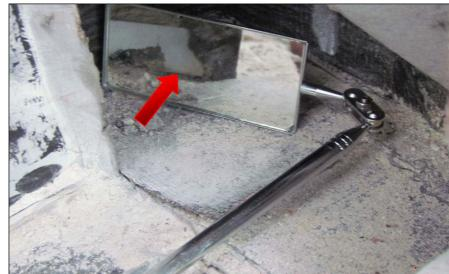
WATER WAS ABLE TO GET IN-BETWEEN THE WINDOW ENO DAM \$ THE MASONRY
